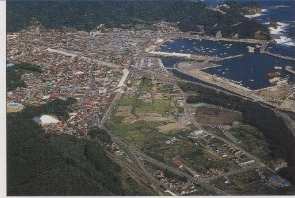
● 防災施設(岩手県田老町) 津波による被害を防ぐために、高い防波堤で町全体をおおっている。
